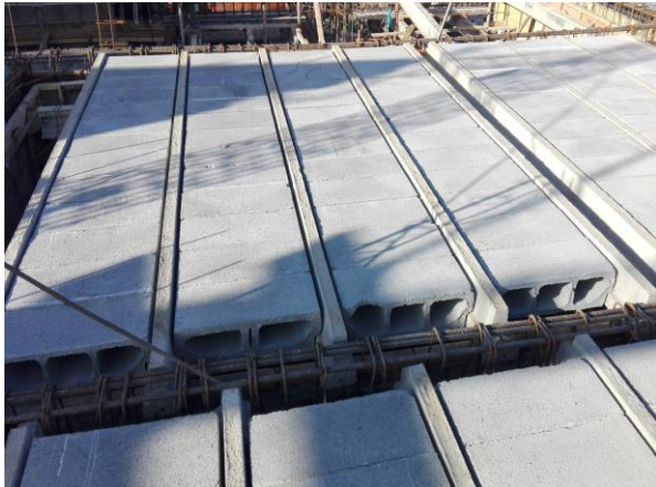
Figura 14. Vista general de la colocación de viguetas y bloques de entrepiso
