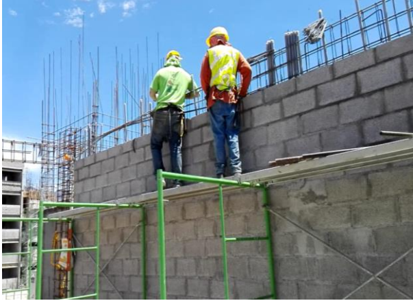
Figura 22. Armado de la viga VH40D.
