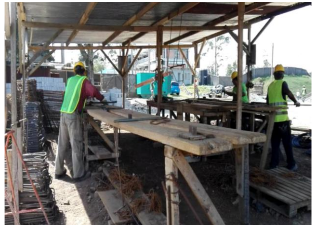
Figura 21. Taller de armadura para el edificio ISLHA y TIC's.
