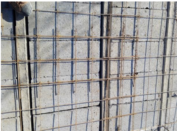
Figura 15. Colocación de malla electrosoldada como acero de refuerzo para entrepiso.
