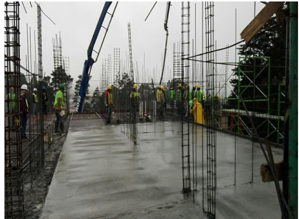
Figura 16. Colado de la losa de entrepiso.
