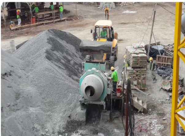
Figura 23. Preparación del concreto.
