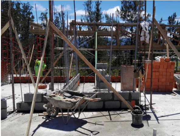
Figura 19. Construcción de paredes de bloques de concreto.
