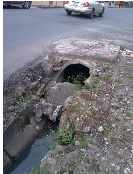
**Figura 1.7.** Sección de alcantarilla en estado de deterioro. Imagen propia.
