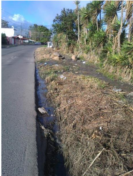
**Figura 1.5.** Ausencia de cordón y caño provoca empozamientos de agua. Imagen propia.
