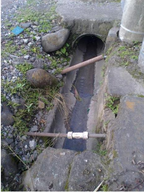
**Figura 1.4.** Tuberías transversales interrumpen curso de agua en sección de caño. Imagen propia.
