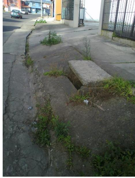
**Figura 1.6.** Tragante ubicado a mayor altura del nivel de caño. Imagen propia.
