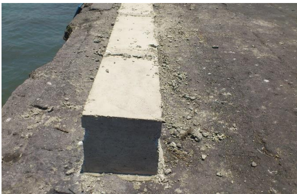
Figura 15. Elementos después de retirar el encofrado. Fuente: Elaboración propia
