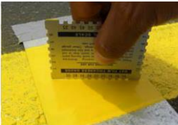
Figura 4. Colocación de una pieza de lámina galvanizada sobre el trazado.
