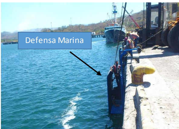
Figura 13. Colocación de la defensa marina. Fuente: Elaboración propia
