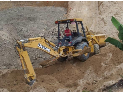
Figura 35. Movimiento de tierra previo para obtener la geometría del muro. (PH Pirris, 2011).
