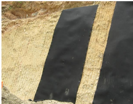
Figura 40. Geodren planar colocado en la cara interna del muro. (PH Pirrís, 2011)
