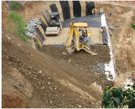
Figura 47. Colocación y extendido del geotextil tejido además del material de relleno. (PH Pirris, 2011)
