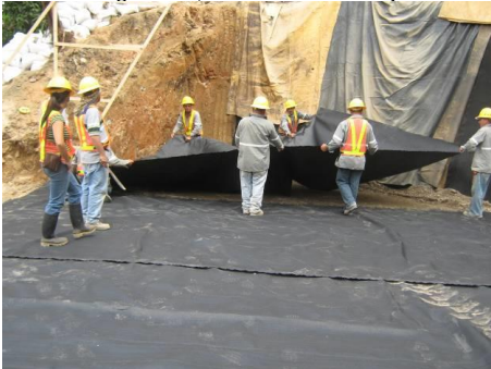
Figura 42. Colocación y extendido del geotextil tejido. (PH Pirris, 2011)
