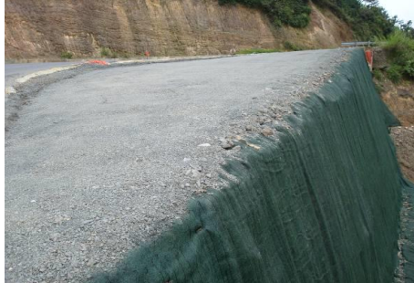
Figura 55. Colocación y extendido del material sobre el muro para colocar la capa asfáltica. (PH Pirris, 2011)
