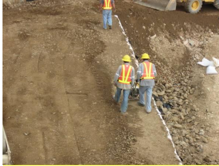
Figura 46. Compactación del borde de la cara externa del muro de suelo reforzado. (PH Pirris, 2011)
