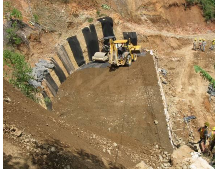
Figura 51. Extendido del material de relleno de manera mecánica. (PH Pirris, 2011)
