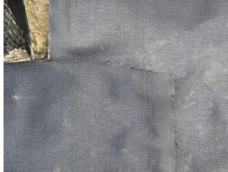
Figura 43. Traslape de 30cm entre tiras de geotextil tejido. (PH Pirris, 2011)
