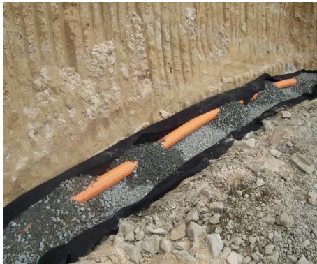
Figura 39. Drenaje interno del muro de suelo reforzado. (PH Pirrís, 2011)
