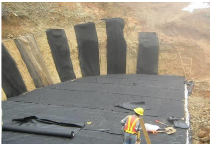
Figura 18. Separación del material de relleno para el muro por las capas, PH Pirrís.
