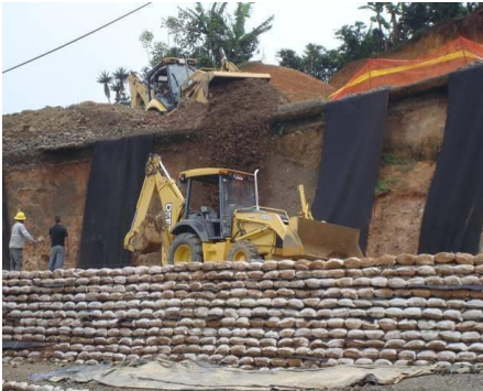
Figura 45. Colocación y extendido del material de relleno para las capas del muro. (PH Pirris, 2011)
