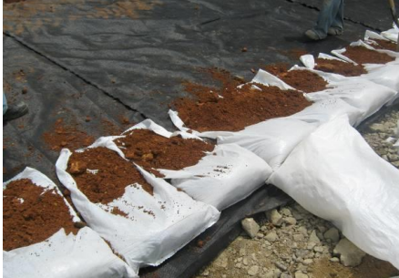
Figura 53. Colocación de sacos para fallada externa del muro. (PH Pirris, 2011).
