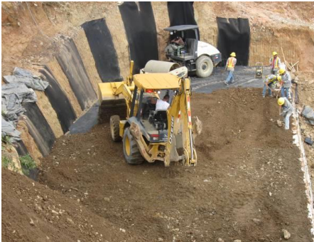
Figura 50. Extendido del material de relleno de manera mecánica y manual. (PH Pirris, 2011)
