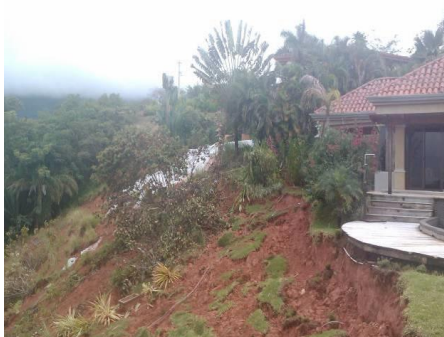
Figura 4. Fotografía del proyecto muro Bob en la zona de dominical.
