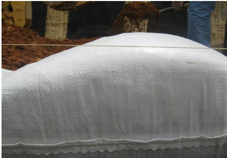
Figura 54. Nivel para cada capa del muro de suelo reforzado. (PH Pirris, 2011)
