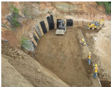
Figura 12. Fotografía del muro de suelo reforzado PH Pirris.
