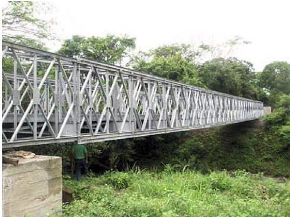
Figura 22 Puente tipo Bailey sobre río Potrero (www.costricahoy.info)
