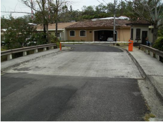
Figura 51 Vista puente S2
