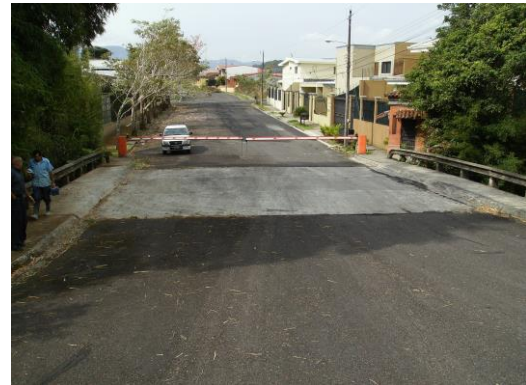
Figura 50 Vista puente S1
