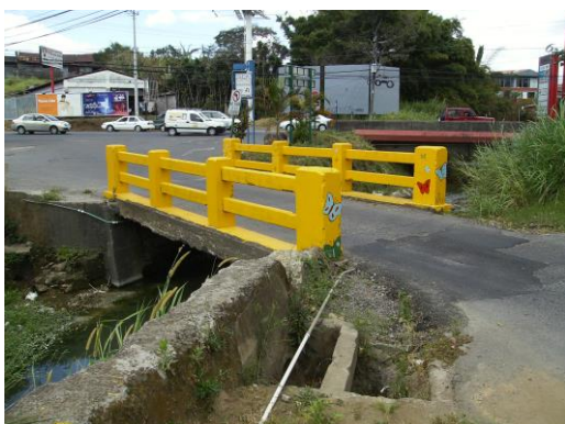
Figura 45 Vista puente C1
