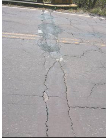
Figura 6-13 Sobrecapas sobre las juntas de expansión (grado 5)
