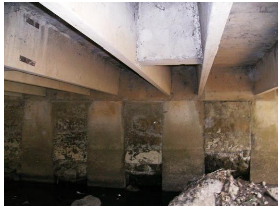
Figura 54 Vista inferior puente S5
