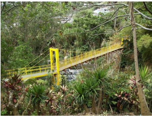
Figura 48 Vista puente C4
