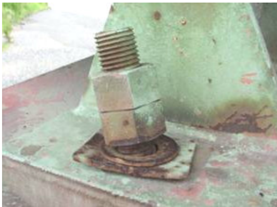
Figura 6-33 Deformación del perno
