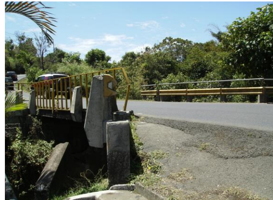
Figura 62 Vista puente G8
