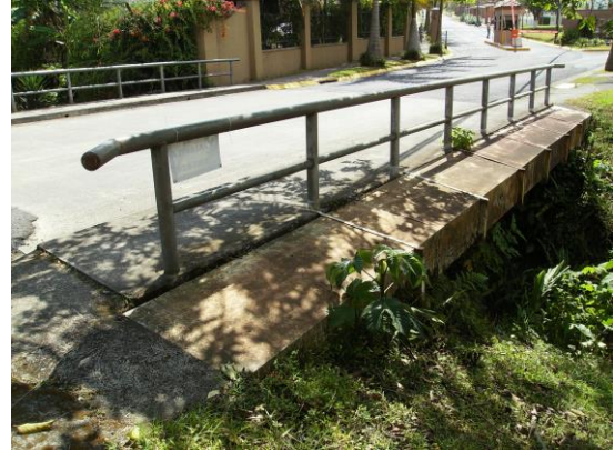
Figura 61 Vista puente G7
