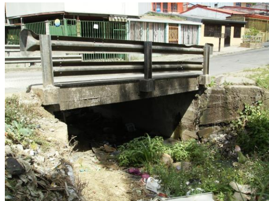
Figura 58 Vista puente G4
