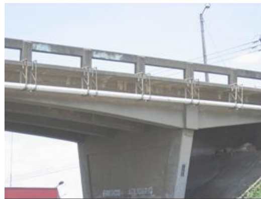
Figura 1.29 Apoyo rígido (concreto)
