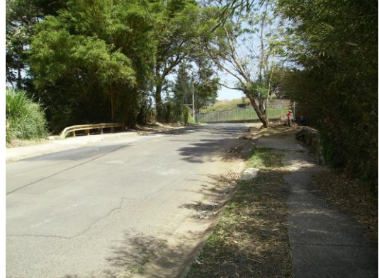
Figura 53 Vista puente S4
