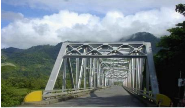
Figura 11 Superestructura de cerchas. Puente sobre río Terraba (www.perezzeledon.net)
