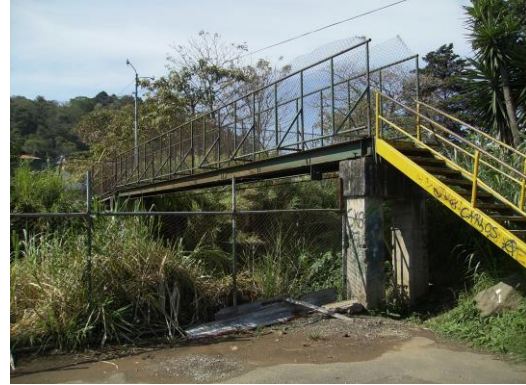
Figura 49 Vista puente C5
