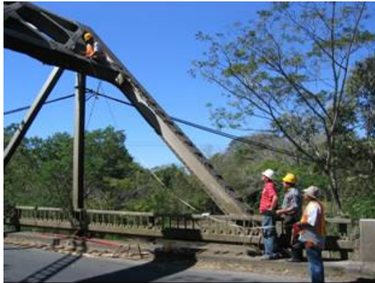
Figura 2-8 Actividades de inspección en alturas
