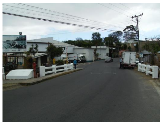
Figura 46 Vista puente C2
