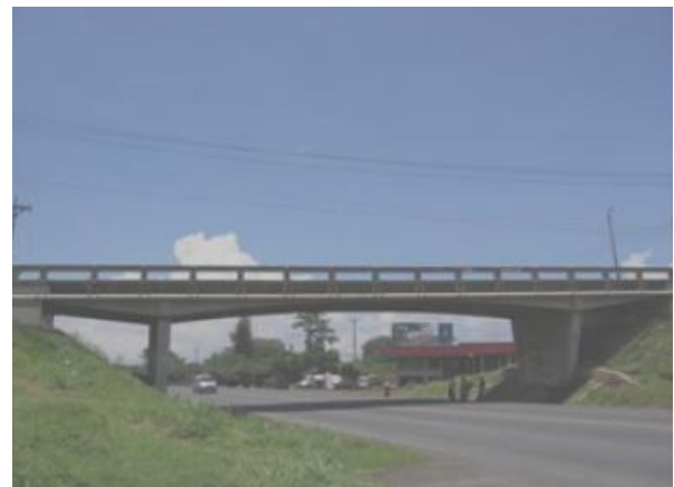
Figura 10 Superestructura de marco rígido (MOPT, 2007)
