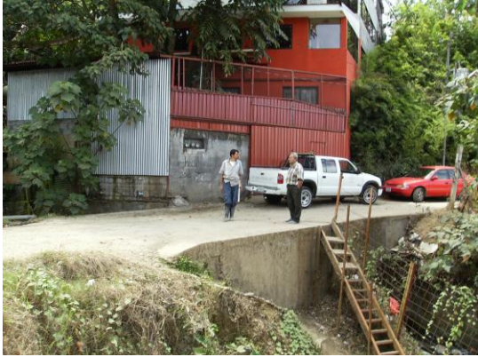
Figura 59 Vista paso de alcantarilla G5
