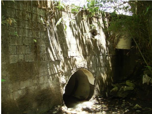
Figura 55 Vista paso de alcantarilla S1
