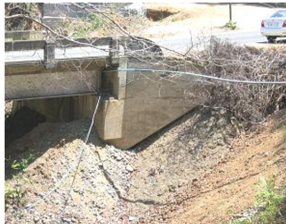
Figura 6-38 Relleno de aproximación
