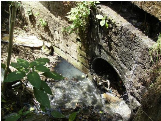
Figura 60 Vista paso de alcantarilla G6
