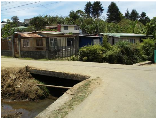
Figura 56 Vista puente G2
