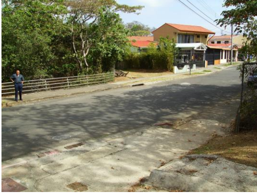
Figura 47 Vista puente C3
