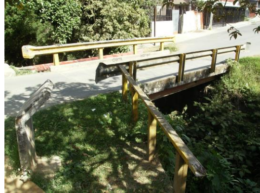
Figura 57 Vista puente G3
