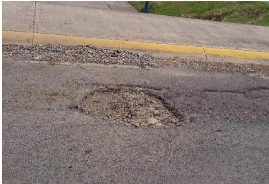
Figura 4. Bache en pavimento flexible. Fuente: Propia (2016).
