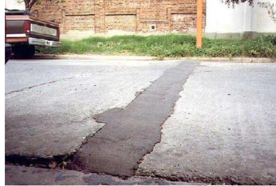
**Figura 14.** Levantamiento de losas de concreto. Fuente: Calo, D. (2008).
