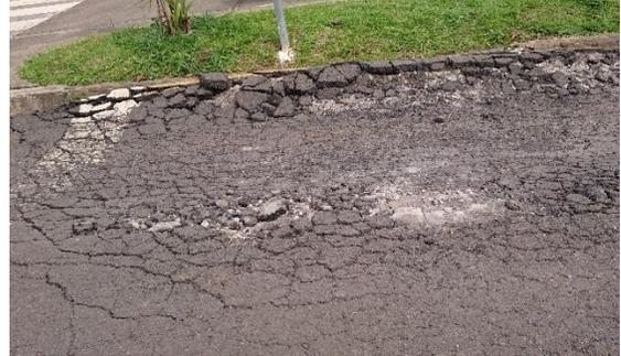
**Figura 7.** Fenómeno "piel de cocodrilo" en pavimento flexible. Fuente: Propia (2016).
