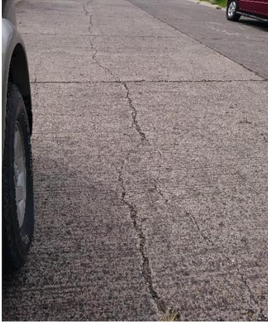
**Figura 11.** Fisura longitudinal en pavimento rígido. Fuente: Propia (2016).
