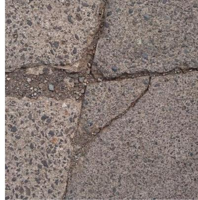
**Figura 12.** Rotura de esquina en losa de concreto. Fuente: Propia (2016).
