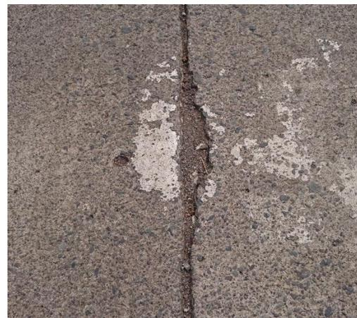
**Figura 15.** Despostillamiento de juntas en la losa. Fuente: Propia (2016).
