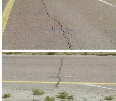
Figura 5. Agrietamiento en un pavimento flexible. Fuente: SIECA (2000).
