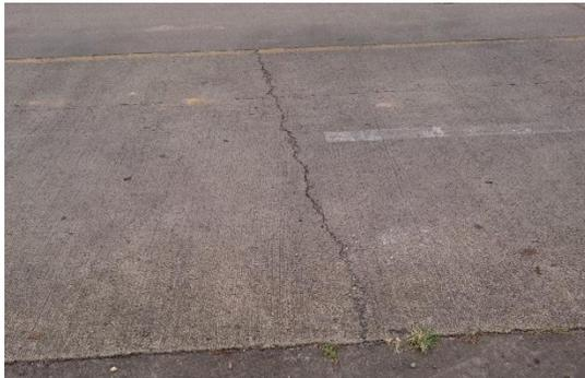
**Figura 9.** Fisura transversal en pavimento rígido. Fuente: Propia (2016).
