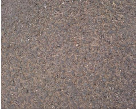
**Figura 6.** Desgaste superficial de la carpeta asfáltica. Fuente: Propia (2016).
