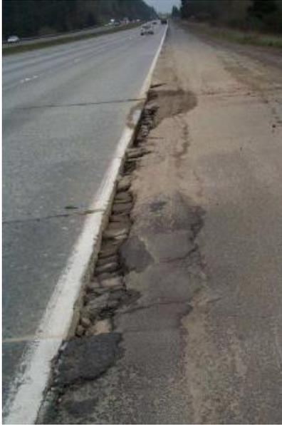
**Figura 13.** Efecto de la erosión por bombeo en pavimento de concreto. Fuente: Calo, D. (2008).
