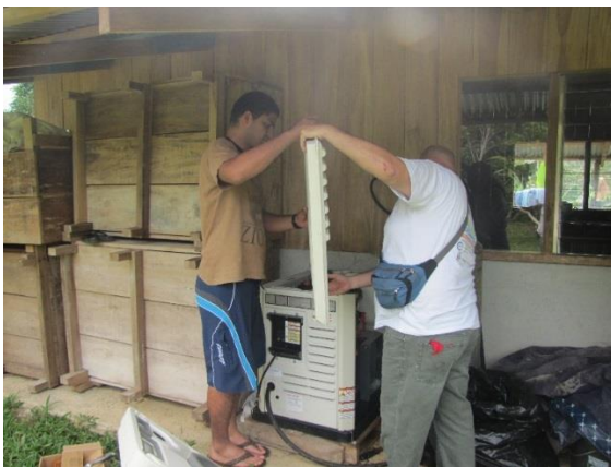
Figura 6. Revisión de equipos y pruebas de funcionamiento.
