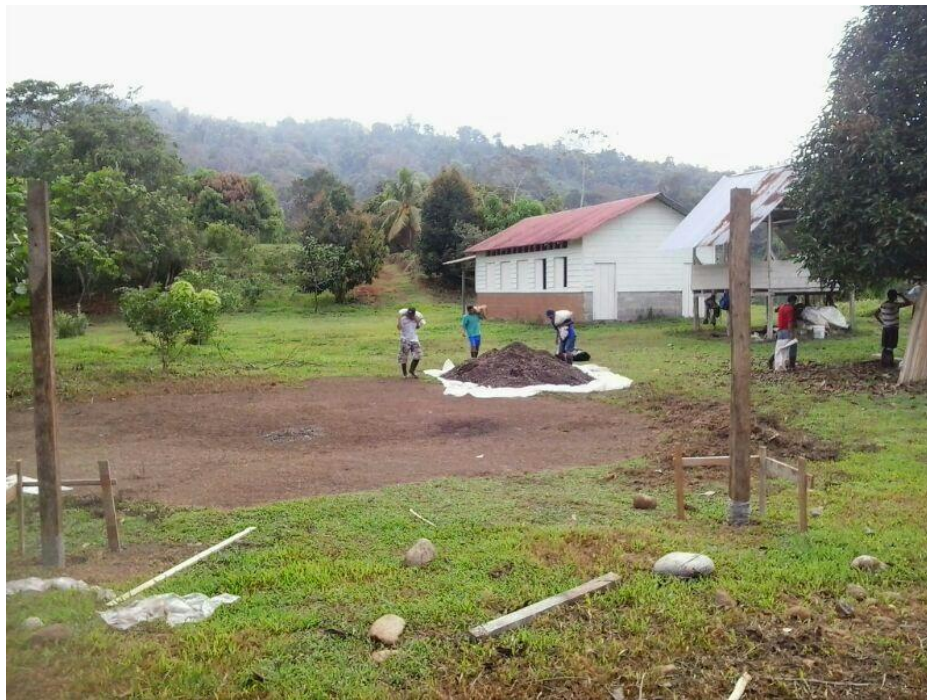
Figura 46. Inicio de construcción de centro de acopio (Mayo, 2014)
