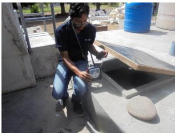
Medición inicial del tanque de lodos
