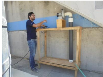
Montaje del filtro en el sitio
