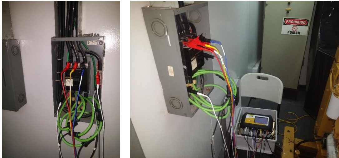
Figura 5.1. Instalación del Power Guía 440S. Fuente: fotografía propia.
