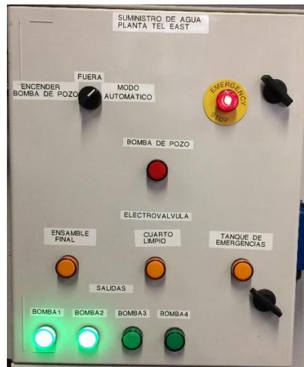
Figura 5.10. Imagen frontal del Panel de Control
