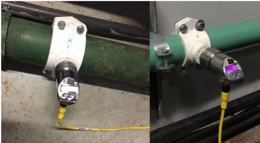
**Figura 5.7. Sensores de velocidad instalados en la planta**
