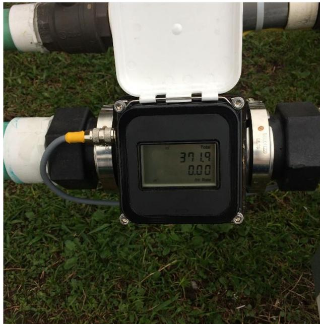
Figura 5.3. Sensor Seametrics WMP instalado en la planta
