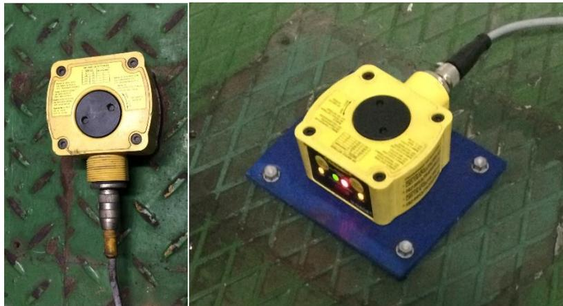
**Figura 5.9. Montaje de los sensores de los tanques de proceso**
