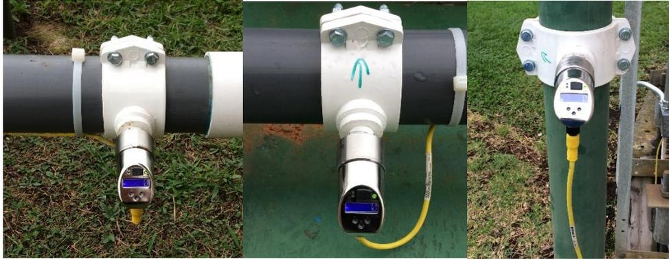
**Figura 5.6. Interruptores de flujo instalados en la planta**
