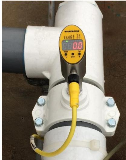
**Figura 5.8. Montaje del transmisor de presión en la tubería principal**
