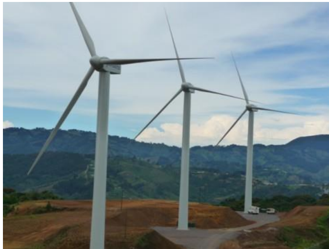
Figura 3.1 Aerogeneradores de eje horizontal y tres palas, Parque Eólico Los Santos Fuente: COOPESANTOS (2011)
