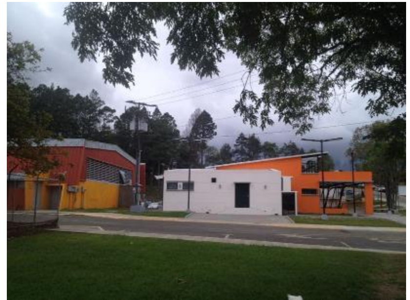
Ilustración 10, Instalaciones existentes- relaciones con el contexto. FUENTE: Elaboración propia.
