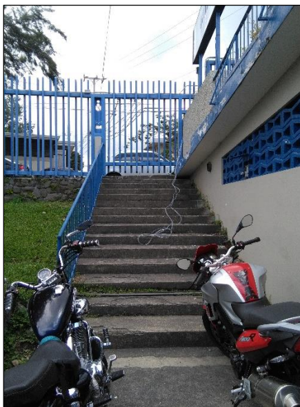
Figura V.14. Espacio cercano a la entrada de funcionarios ubicada en el segundo piso
