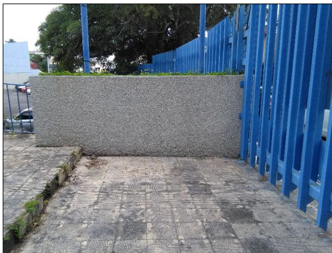
Figura V.15. Muro de separación existente entre los espacios
