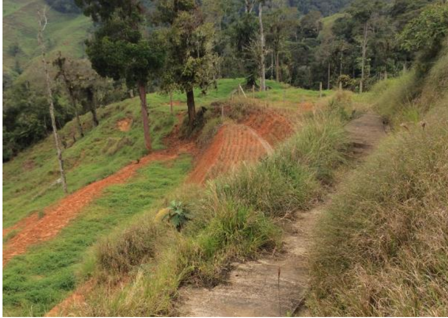
Figura N° 8. Solución provisional de Vetiver en el primer talud y en el intermedio. De igual manera, en la berma intermedia
