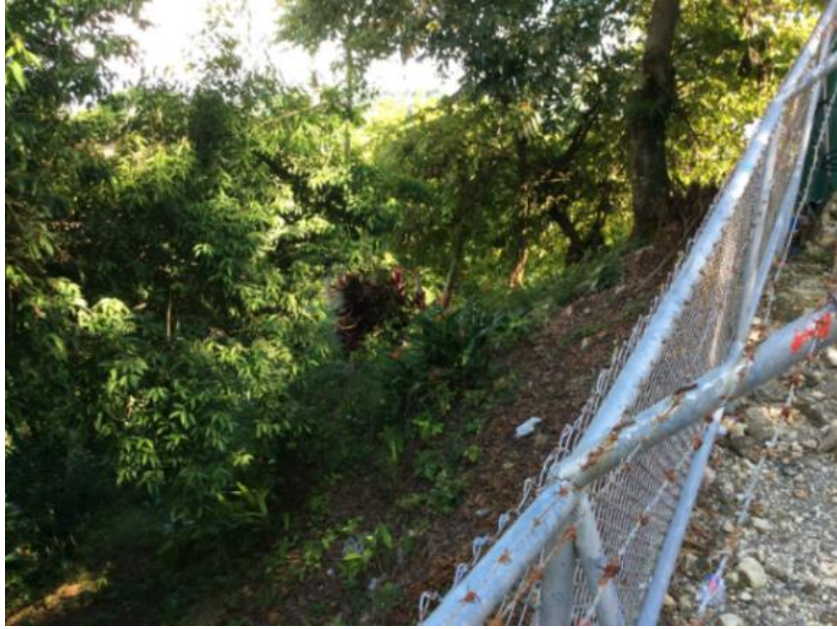
Figura N° 12. Ilustración del talud de colindancia con la propiedad
