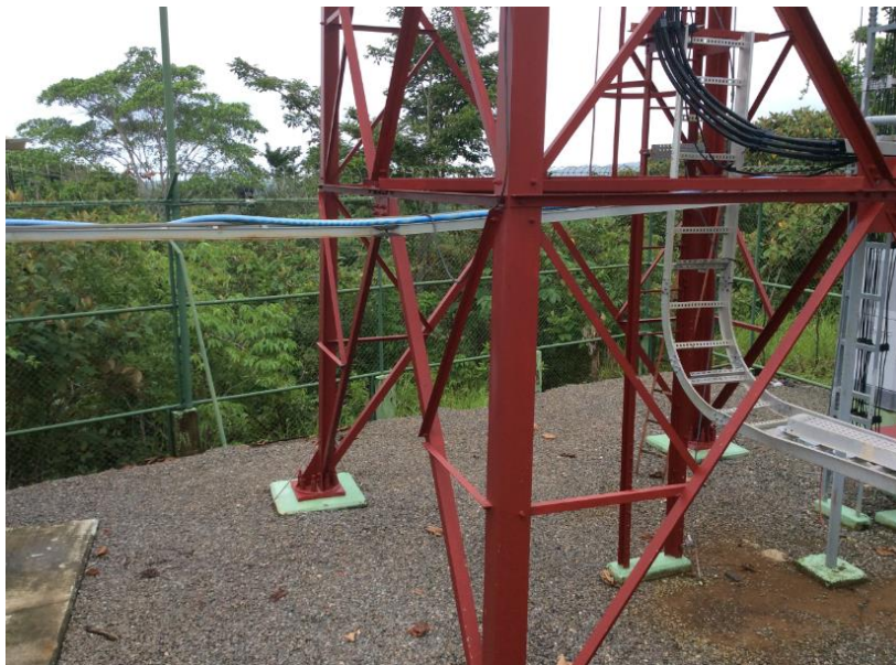
Figura N° 17. Cimentación de la torre cercana al perfil del talud en estudio (al fondo)
