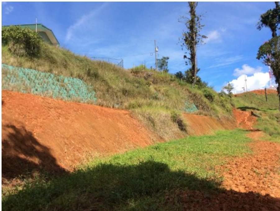
Figura N° 9. Fotografía de la conformación en bermas del talud
