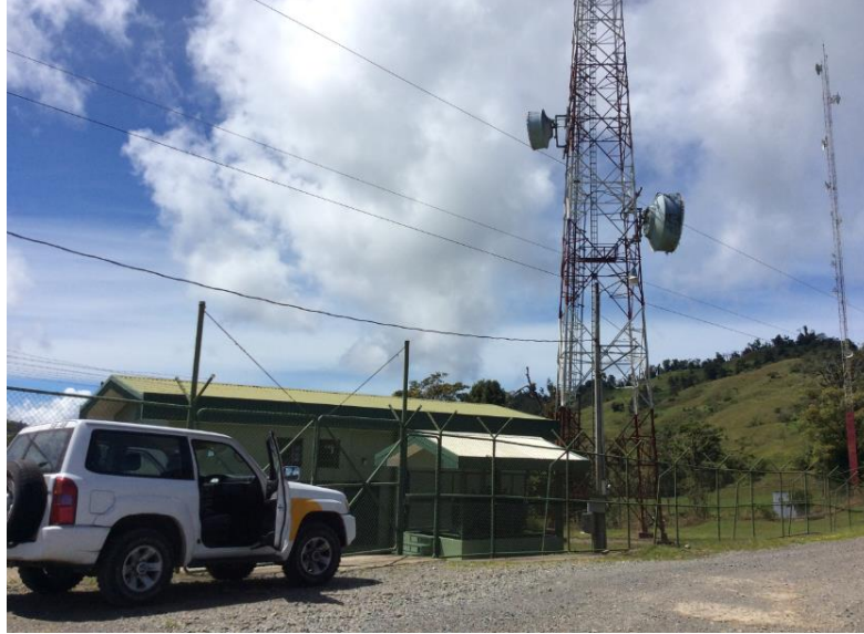
Figura N° 6. Perfil de la Central Telefónica Cerro Savegre. El talud de intervención ingenieril se ubica en el costado izquierdo de la figura
