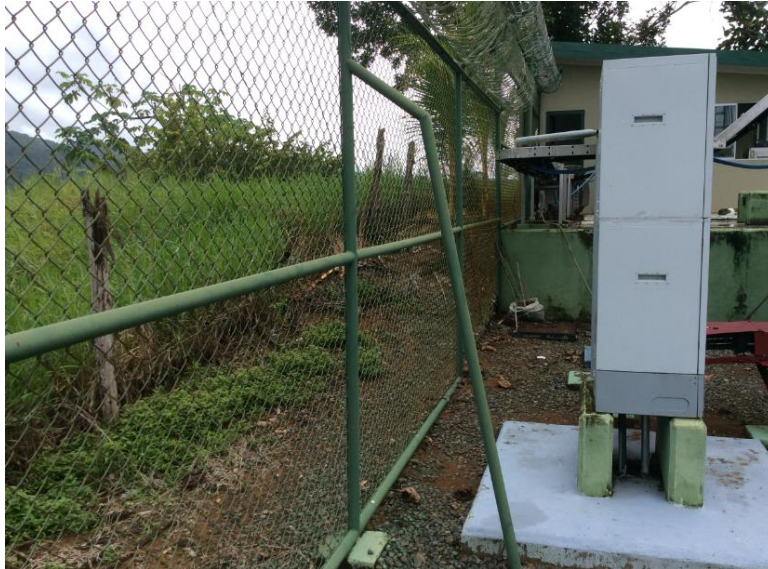
Figura N° 14. Lindero en la margen izquierda de la Radio Base
