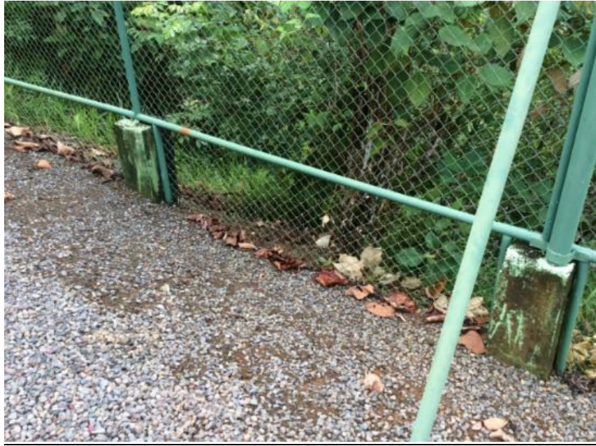
Figura N° 16. Fotografía del perfil del talud levantado
