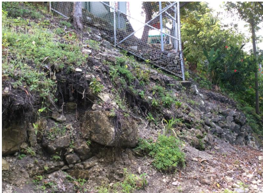
Figura N° 13. Exposición de una esquina del perímetro de la Central
