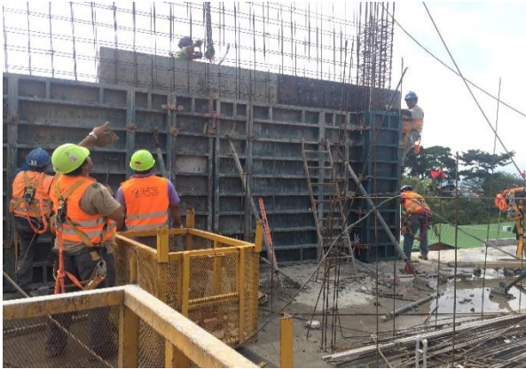
Figura 8. Muro encofrado y apuntalado con el sistema PERI.
