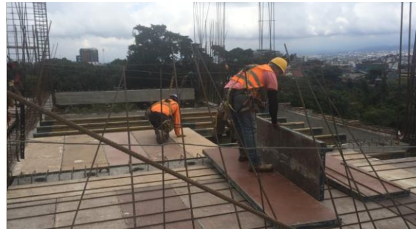
Figura 10. Colocación de paneles de encofrado de entrepiso.
