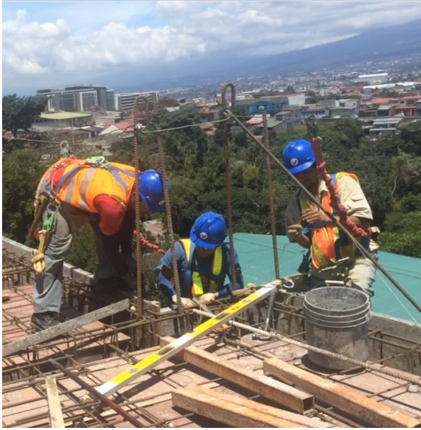
Figura 12. Colocación de paneles de encofrado de borde en losa.
