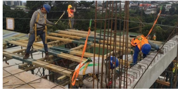
Figura 9. Colocación de viguetas para encofrado de entrepiso.
