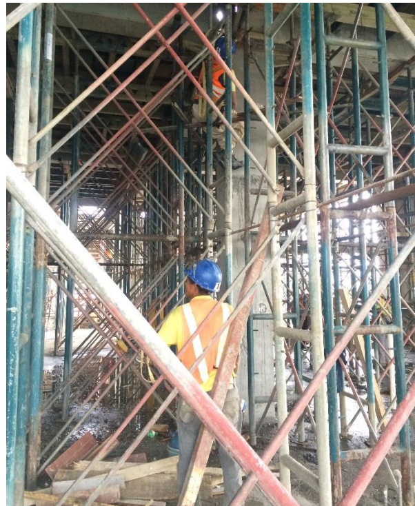
Figura 11. Encofrado de nudo de unión entre viga y columna.
