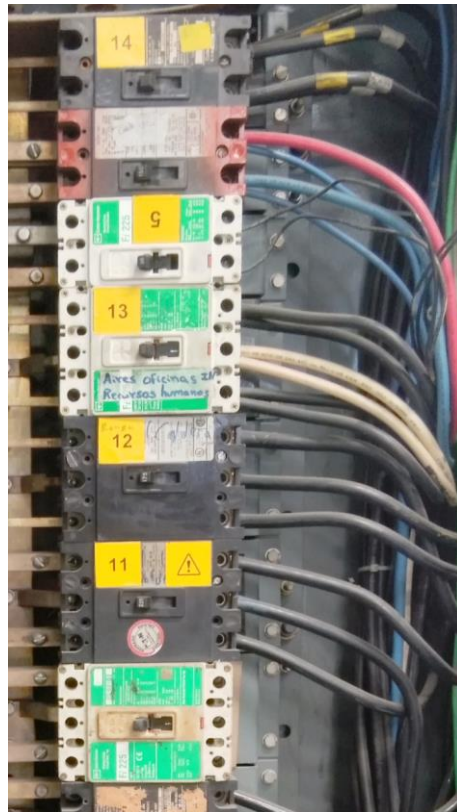
Figura 23. Circuitos ramales en paralelo en el Tablero TA-9-3
