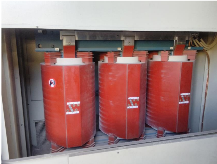
Figura 30. Transformador principal de 1200 KVA abierto
