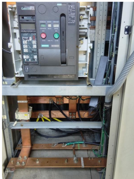
Figura 31. Disyuntor principal y barras de neutro y tierra unificadas
