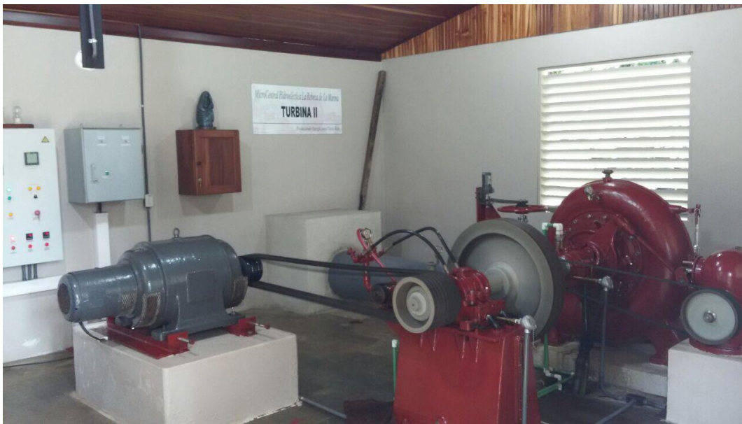
Figura 1. Micro central hidroeléctrica La Rebeca de La Marina previo a la intervención (Fuente: Fotografía en la micro central).
