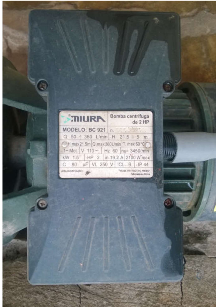
Figura 8 Bomba para agua caliente. Tomada por: Diego Elizondo.
