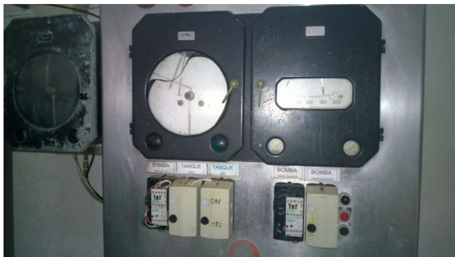
Figura 13 Panel de indicadores del sistema de pasteurizado. Tomada por Diego Elizondo.
