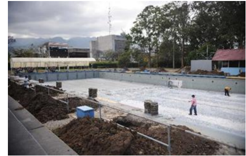
Imagen 1. Reparaciones en la instalación acuática Piscina del María del Milagro París.
