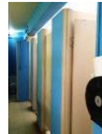
Imagen 62. Servicios Sanitarios. Fuente: Propia
