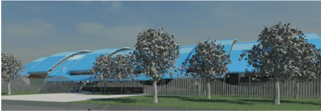
Imagen . Acceso peatonal por el lago
