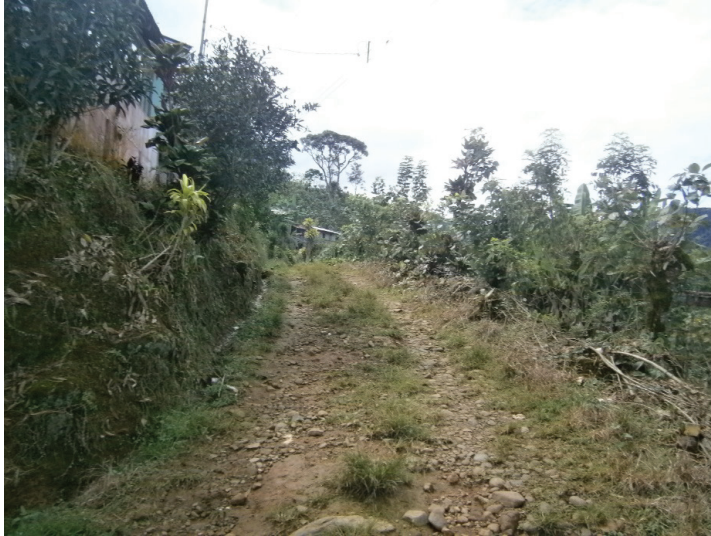
Figura 5.2. Agua residual tipo gris en caños sin concreto.
