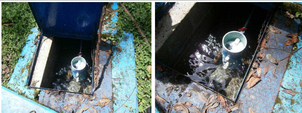
Cuadro 4.14. Ficha de campo SERSA sistema de cloración en el tanque clorador Río Macho.
