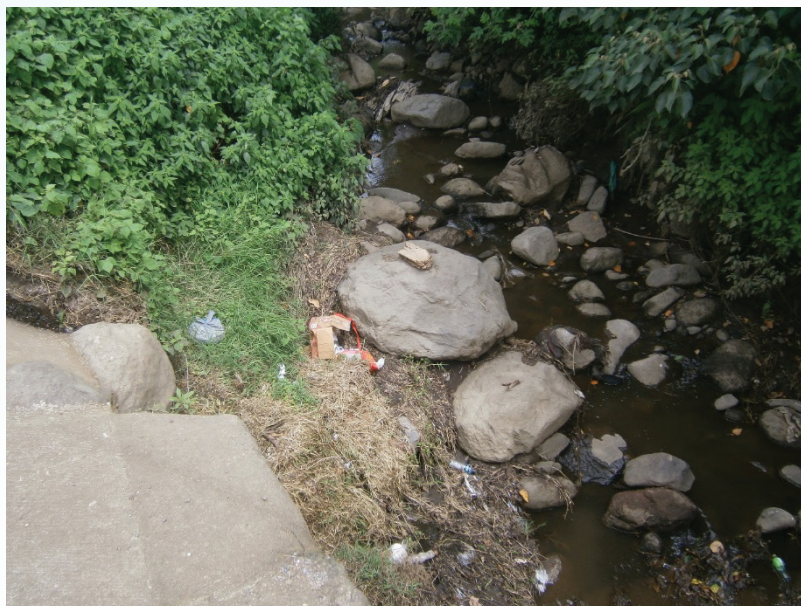
Figura 5.1. Río Páez aguas arriba, presencia de residuos sólidos y contaminación de agua.
