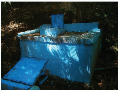
Captación A nivel
