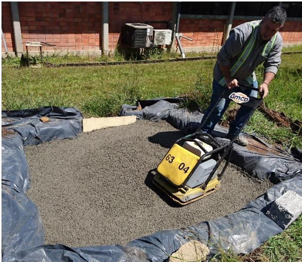
Figura 12. Compactación con plancha de la loseta.
