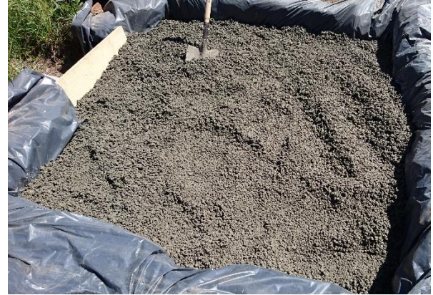
Figura 21. Proceso de construcción de la loseta
