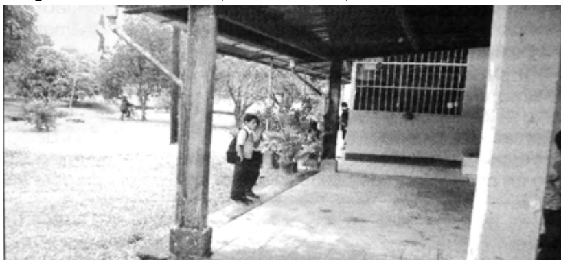
Imagen MR-12. Sistema construido importado: Van Dam.
