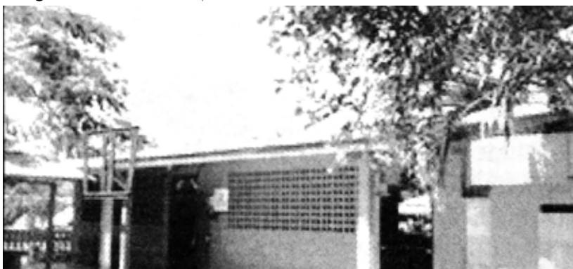
Imágen MR-9. Aula bajo sistema constructivo de bloques en concreto.
