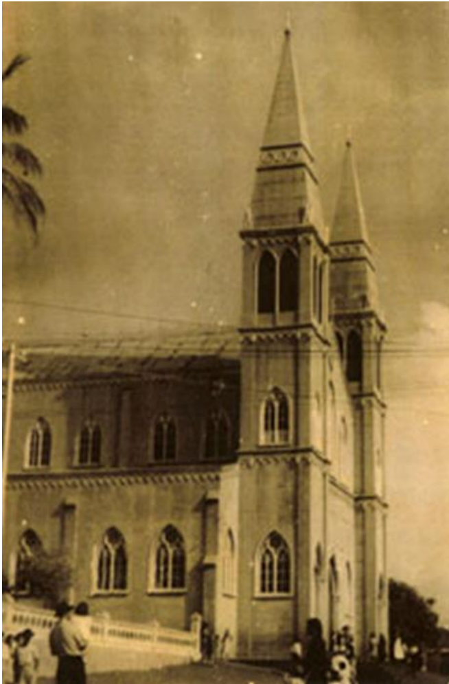
Figura 26. Templo metálico recién construido.
