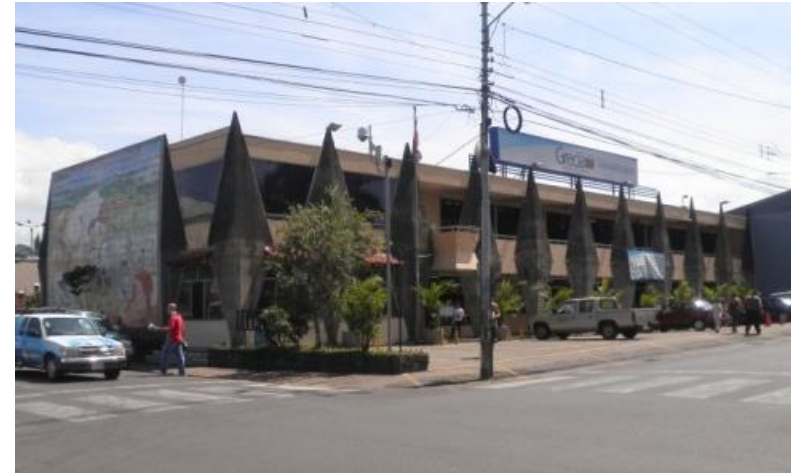
Figura 3. Vista reciente del Edificio Municipal.
