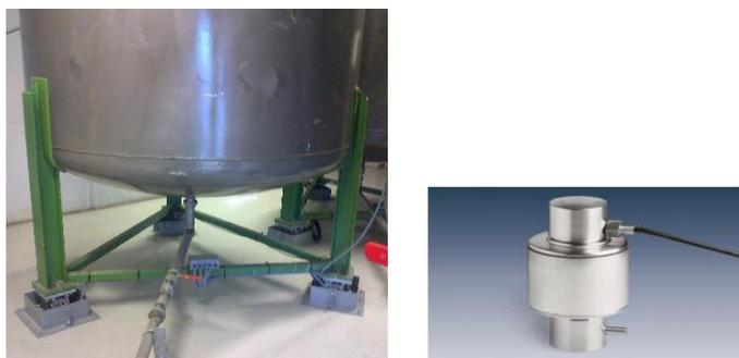
*Figura 3.3 Celdas de carga en el silo (montaje, célula)*
