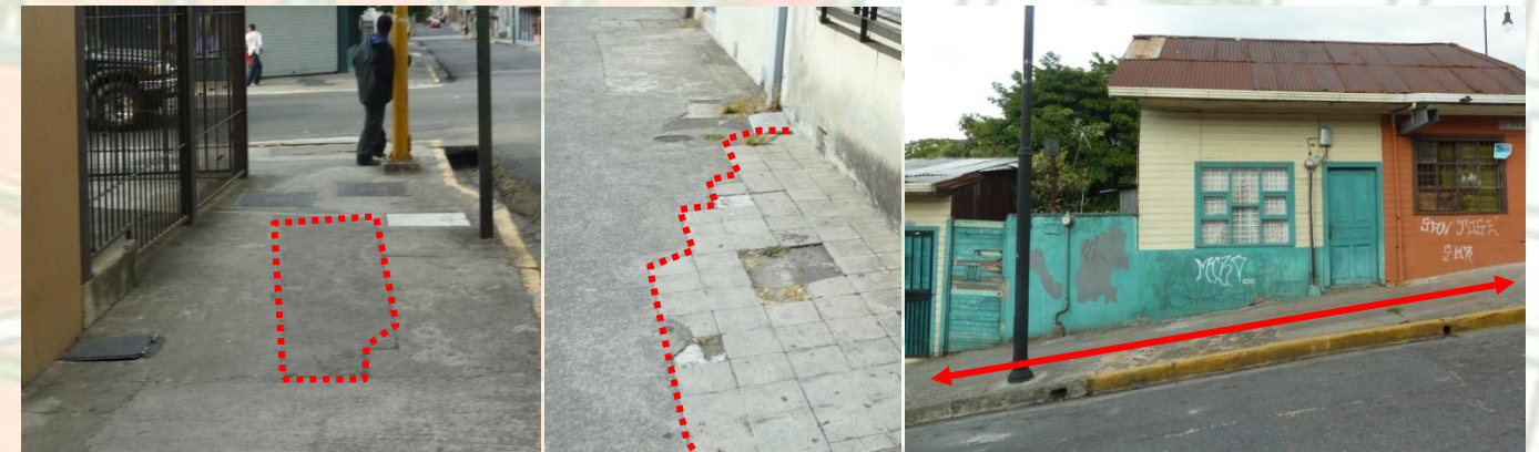
Figura #58. Irregularidad de las superficies de las aceras en la zona de estudio. Fuente: propia.
