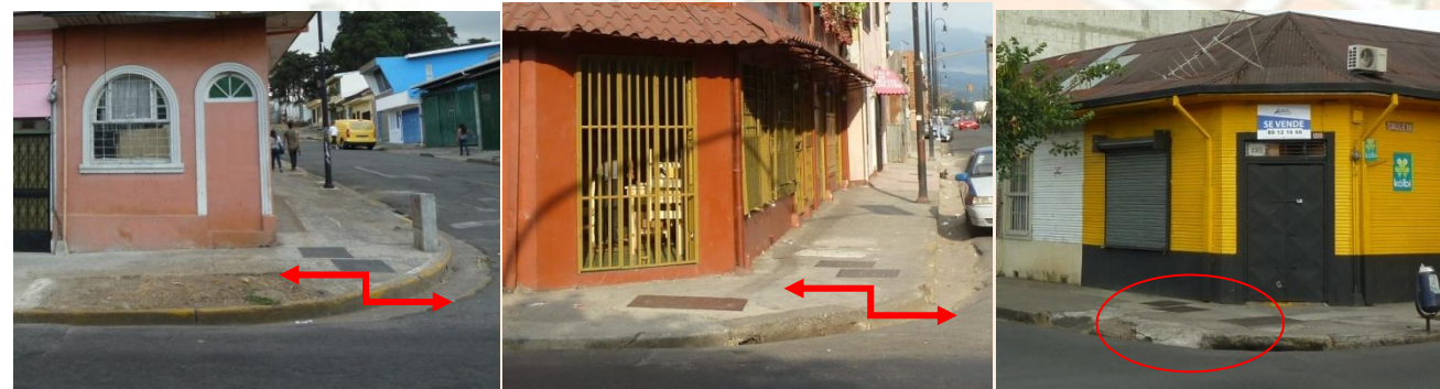
Figura #57. Ausencia de rampas en esquinas y cruces de calles de los barrios o con deficiente señalización.
