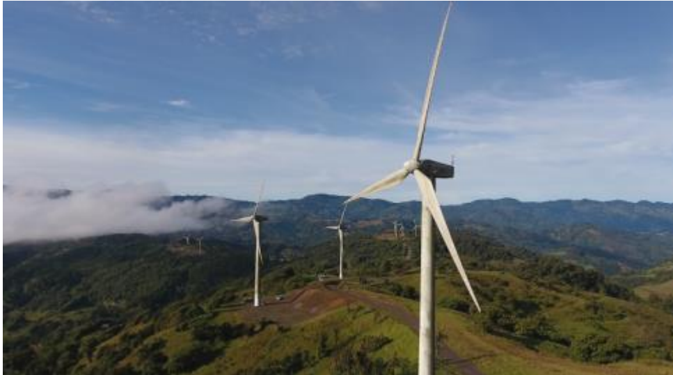
Figura 3.1 Aerogeneradores de eje horizontal y tres palas, Parque Eólico Los Santos
