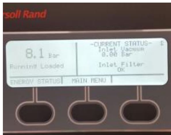
Figura 4.8 Estado del filtro de succión Fuente: J. González (2017)
