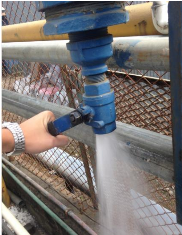
Figura 3.4 Agua presente dentro de la tubería de aire de la empresa.
