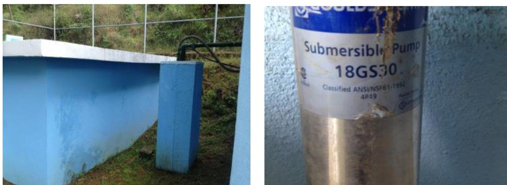
**Figura 14.** Tanque de almacenamiento y tanque enterrado y bomba sumergible GOULD 18GS30 del acueducto de San Francisco
