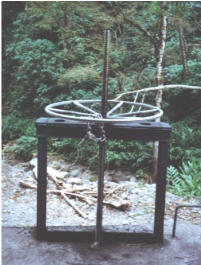
Figura A4. Fotografía de Rueda Giratoria, Desarenadora Toma Birrís Alto
