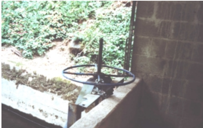
Figura A6. Fotografía de Rueda Giratoria, Compuerta Reguladora Toma Birrís Alto
