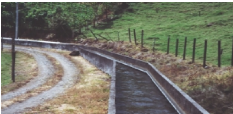
Figura A10. Fotografía de canal Oriental Desarenador Maravilla
