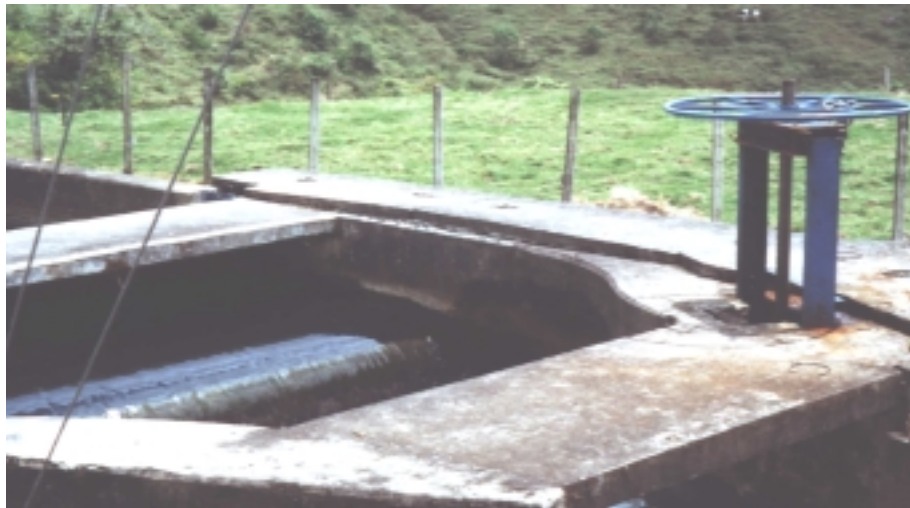
Figura A9. Fotografía de Rueda Giratoria, Desarenador Maravilla
