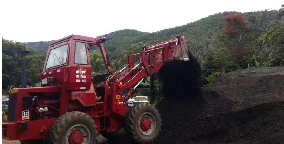
Figura 4.15. Muestra del método de homogenización mecánica mediante retroexcavador. Fuente: Camacho, P.
