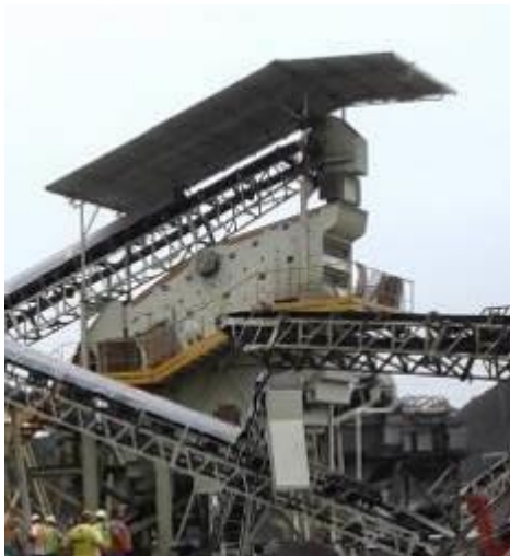
Figura 5.5. Estructura metálica de techo sobre criba
