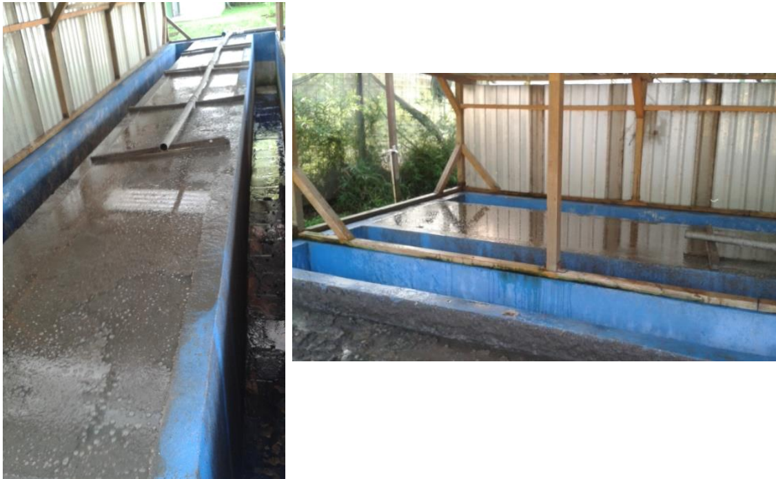
Figura 4. 9. Lecho de secado de la PTAR de Monserrat, Tres Ríos
