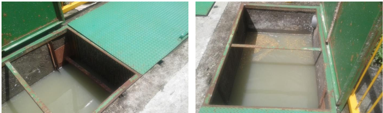
Figura 4. 3. Rebalse de la entrada a la PTAR de Monserrat, Tres Ríos
