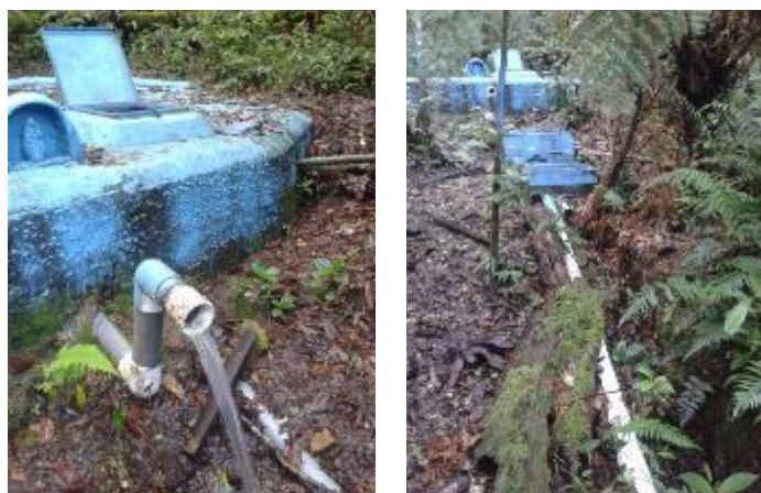
Figura 36. Tubería de rebalse de la Naciente Los Gamboa 2 (imagen de la izquierda) y cajas de registro y línea de conducción de la Naciente Gamboa 2 (imagen de la derecha)
