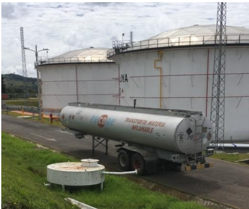
Fotografía 5.4. Tanque de camión cisterna utilizado para el almacenamiento de residuos de hidrocarburos líquidos y lodosos.
