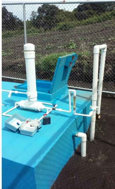
Figura 5.8 Clorador artesanal empleado en ASADA de Potrero Cerrado
