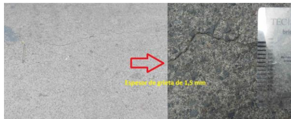
Figura 38: Agrietamiento grado 3.
