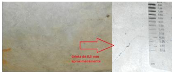
Figura 26: Agrietamiento grado 3.
