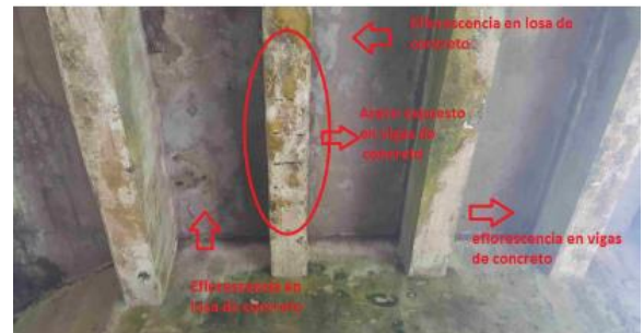
Figura 30: Eflorescencia grado 2.
