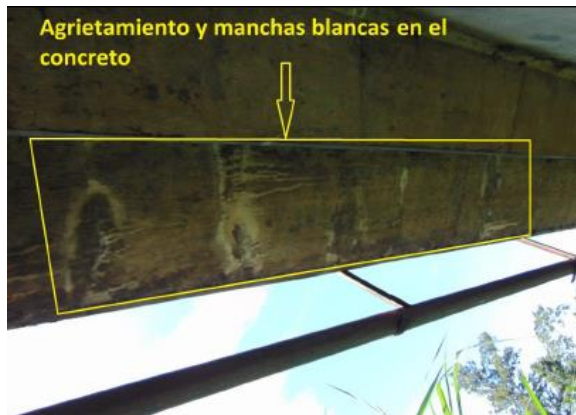
Figura 16: Eflorescencia grado 4.
