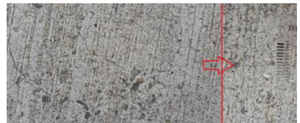
Figura 14: Agrietamiento grado 3.
