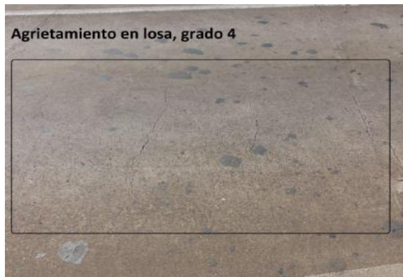
Figura 15: Agrietamiento grado 4.
