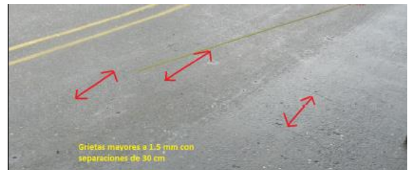
Figura 24: Agrietamiento grado 5.
