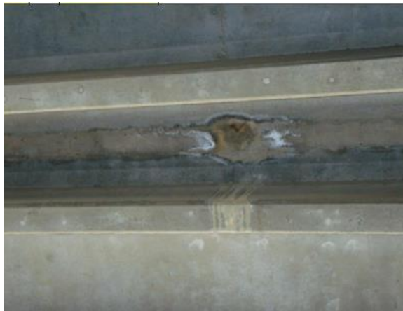
Figura 53: Eflorescencia grado 2.
