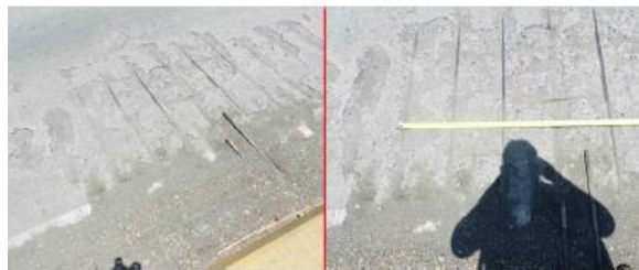
Figura 39: Acero de refuerzo grado 4.
