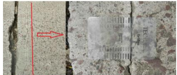
Figura 36: Agrietamiento grado 4.
