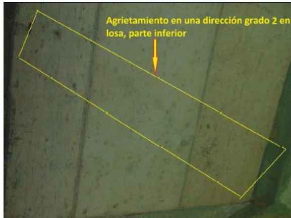
Figura 48: Agrietamiento grado 2.
