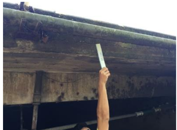
Figura 19: Agrietamiento grado 3.
