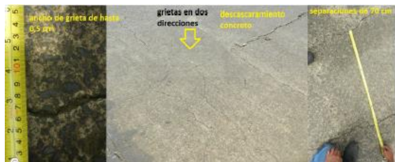
Figura 21: Agrietamiento grado 5.
