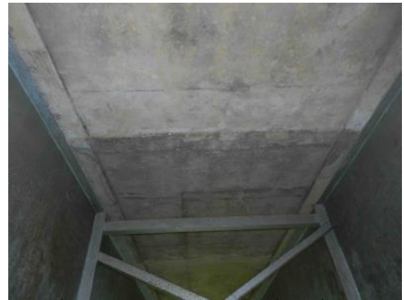
Figura 29: Eflorescencia grado 3.
