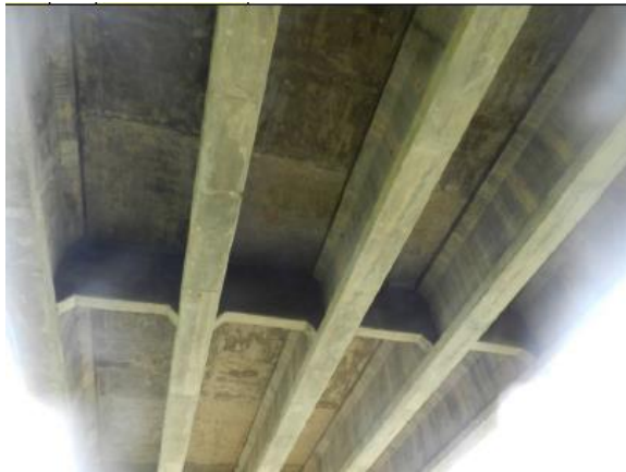
Figura 27: Eflorescencia grado 2.
