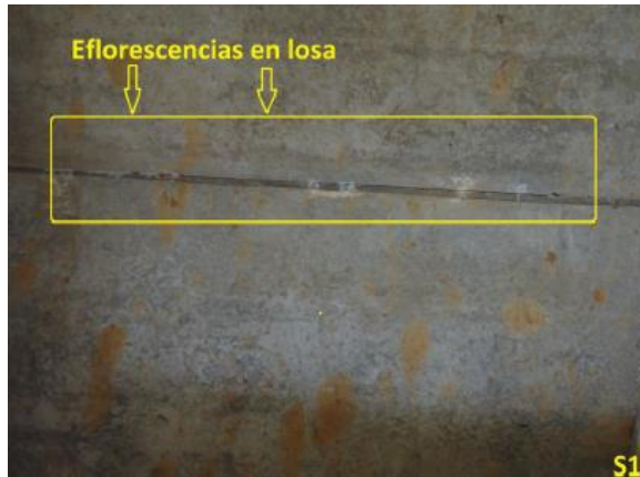
Figura 52: Eflorescencia grado 2.
