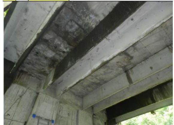
Figura 23: Eflorescencia grado 3.
