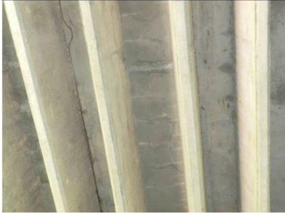
Figura 43: Eflorescencia grado 2
