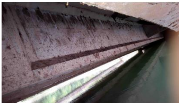
Figura 28: Eflorescencia grado 2.
