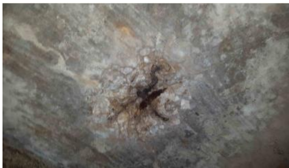
Figura34: Acero de refuerzo grado 3.
