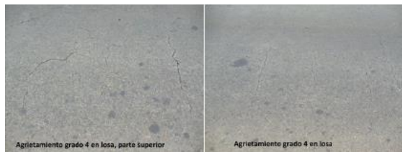
Figura 11: Agrietamiento grado 4.
