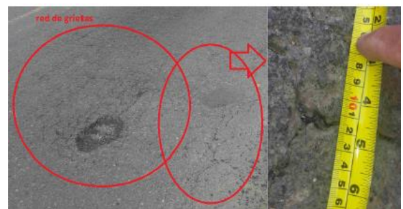
Figura 31: Agrietamiento grado 3.
