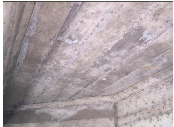
Figura 18: Eflorescencia grado 2.
