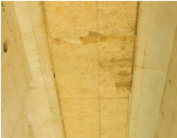
Figura 44: Eflorescencia grado 2.
