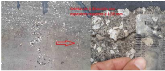
Figura 33: Agrietamiento grado 5.
