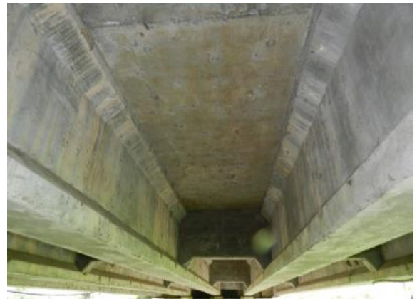
Figura 25: Eflorescencia grado 2.
