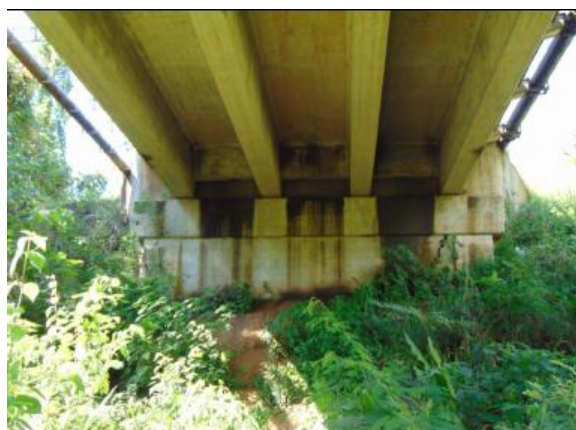
Figura 17: Eflorescencia grado 2.
