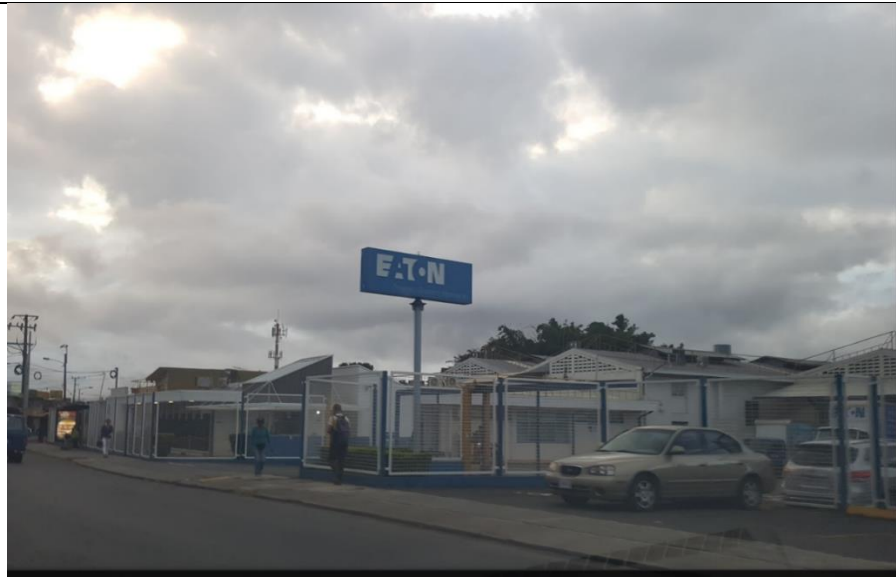
Figura 1.2: Instalaciones Eaton Electrical
