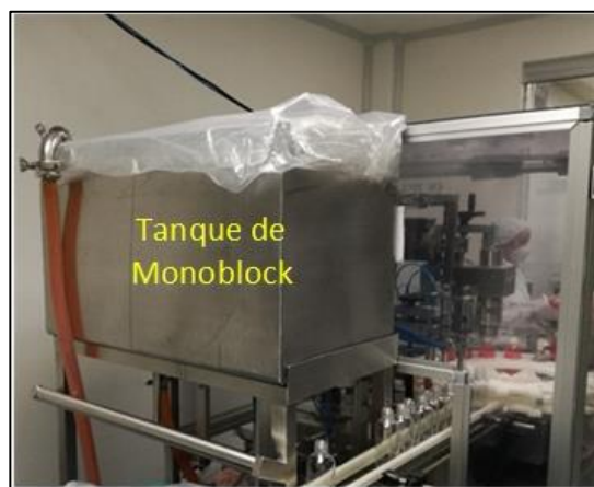
Figura 31. Tanque de Almacenamiento de Monoblock
