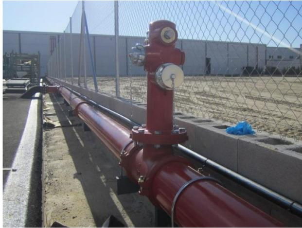
*Figura 7. Sistema de supresión mediante hidrantes*
