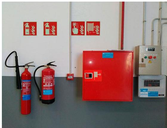
*Figura 8. Sistema de supresión mediante extintores*
