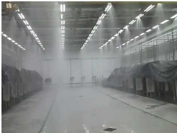
*Figura 20. Sistema de supresión de incendios por medio de rociadores automáticos*
