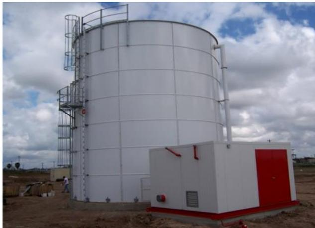
*Figura 15. Tanque de almacenamiento de agua contra incendios*
