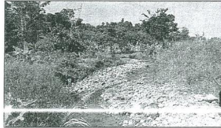
Foto Río Aguas Buenas, vista aguas arriba, del puente
