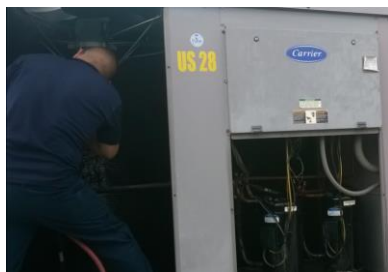
Mantenimiento en una unidad de aire acondicionado
