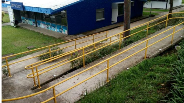
Figura 49. Rampa principal al Edificio de Rectoría de la institución. Fuente: Grupo de trabajo, (2017).
