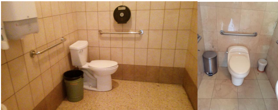
Figura 28. Baños de la edificación. Fuente: Grupo de trabajo, (2017).
