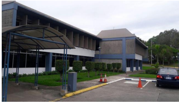
Representación del Nivel del Terreno, donde se encuentra el edificio.
