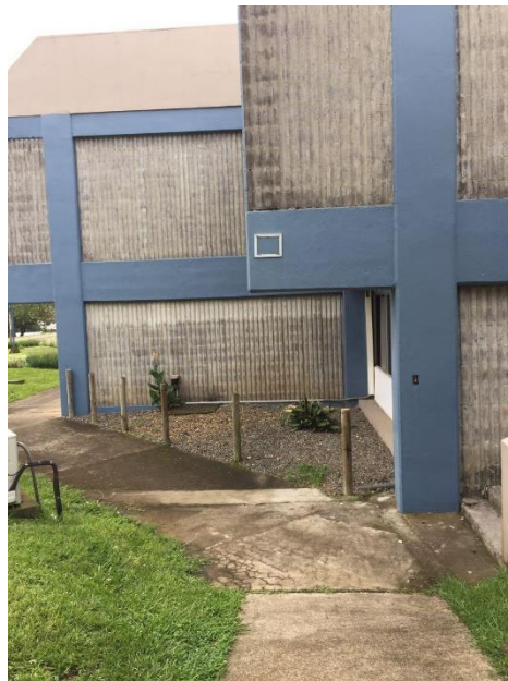
Figura 50. Zona externa del edificio. Fuente: Grupo de trabajo.
