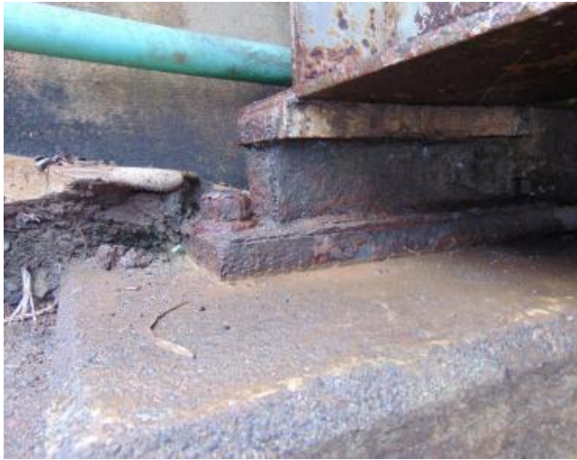
Figura 24. Apoyo convencional fijo en bastiones
