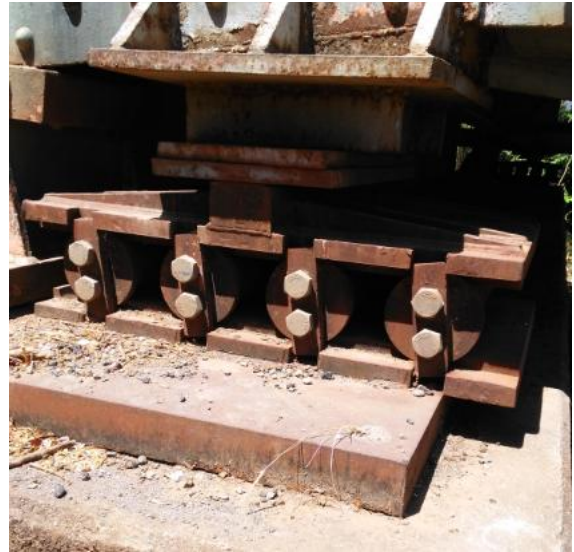
Figura 7. Apoyo combinado (Traslación). Fuente: Propia. Realizado en inspección de puente
