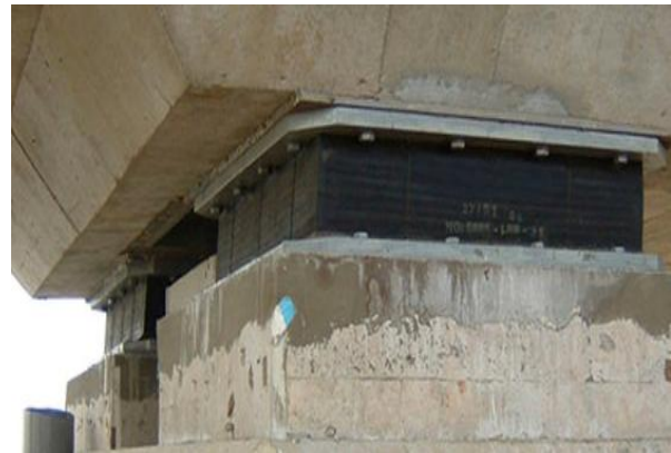
Figura 13. Apoyos Elastoméricos Fuente: Uso de aisladores de base en puentes de concreto simplemente apoyados.
