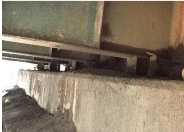
Figura 25. Apoyos convencionales móviles sobre bastión
