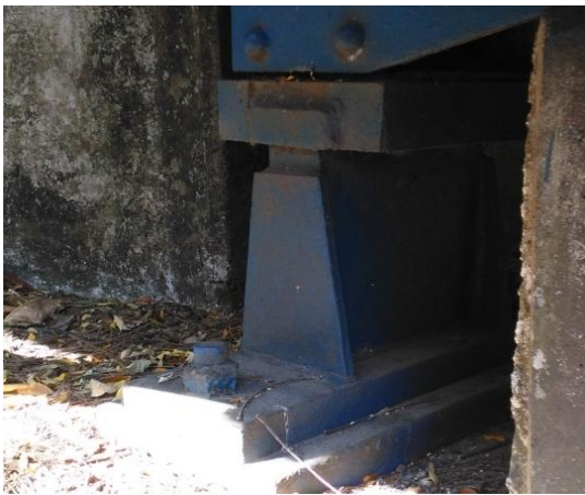
Figura 5. Apoyo Tipo Fijo Fuente: Propia. Inspección de puente realizada
