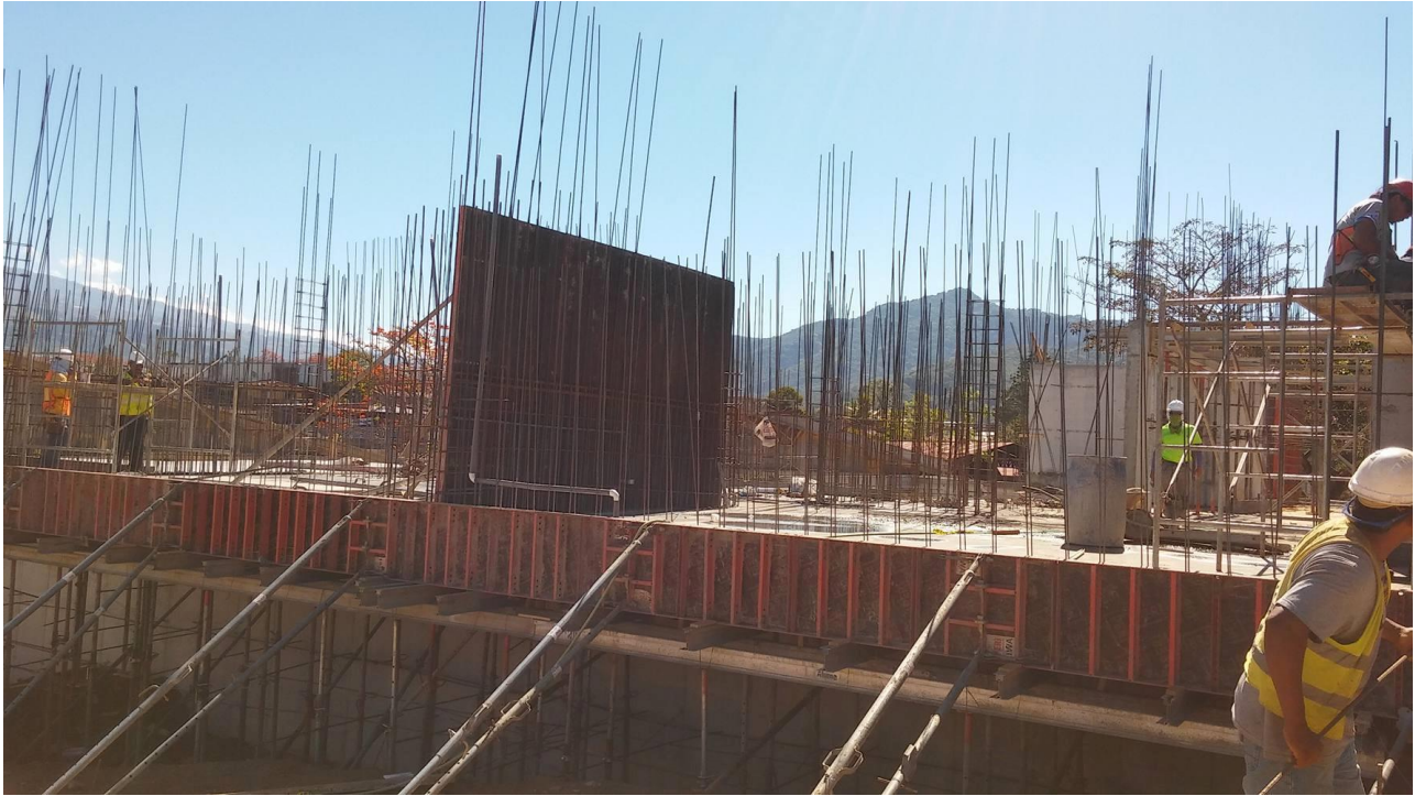
Figura 33. Colocación de formaletas del segundo nivel. Fuente: Elaboración propia Formato Microsoft Excel
