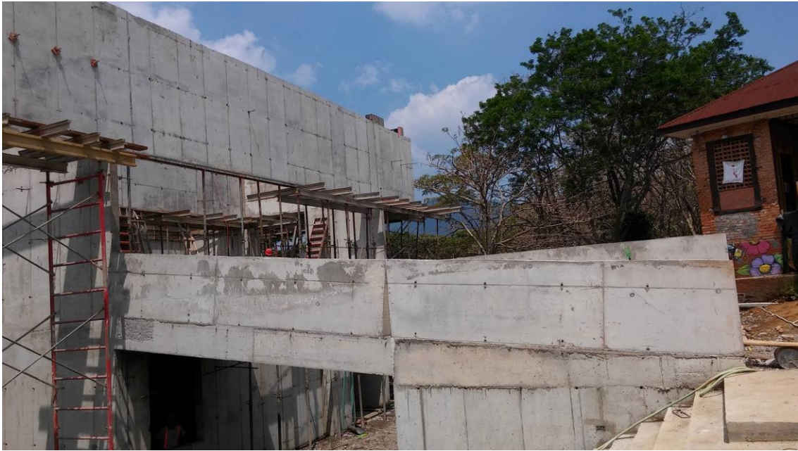
Figura 29. Escaleras al tercer nivel. Fuente: Elaboración propia Formato Microsoft Excel
