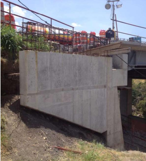
**Figura 05.** Aletón de un puente.
