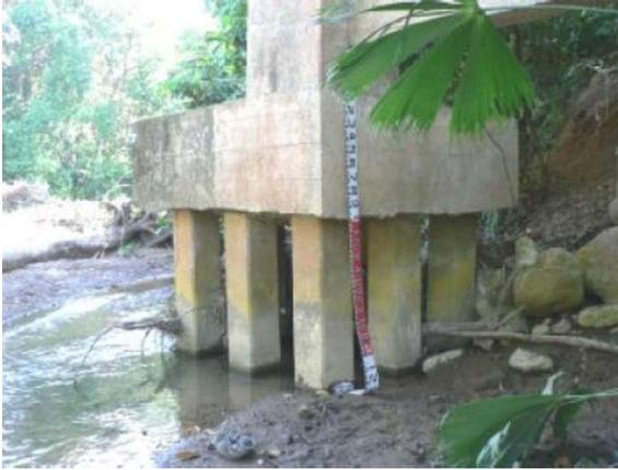
**Figura 04.** Socavación en Bastión de puente.
