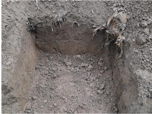
Figura 14. Caja de registro para las válvulas. Fuente: Propia
