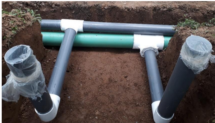
Figura 15. Base para la instalación de la válvula. Fuente: propia.
