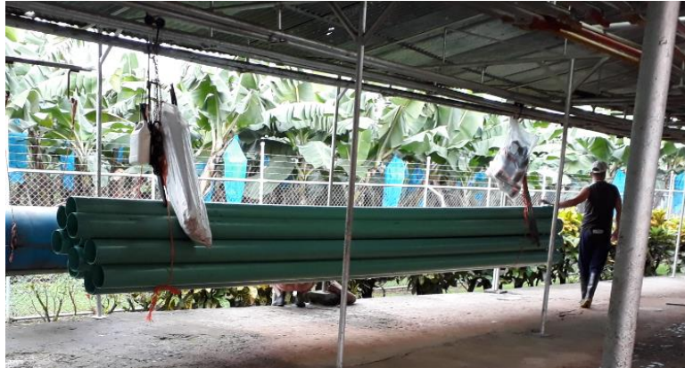
Figura 19. Transporte de la tubería, hasta el área de trabajo. Fuente: propia
