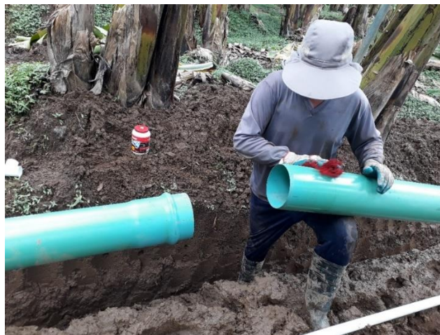
Figura 23. Instalación de los tubos con unión cementada. Fuente: propia
