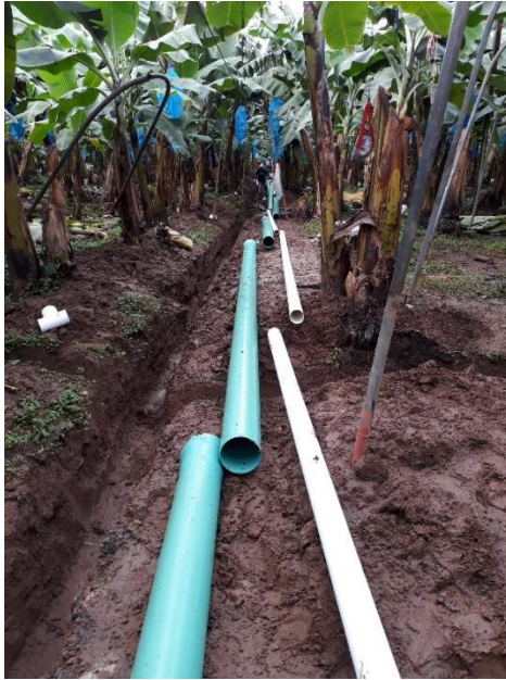
Figura 20. Distribución de la tubería en el campo. Fuente: propia
