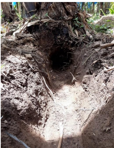
Figura 10. Construcción de túneles en la parte baja de la planta para la instalación de los laterales. Fuente: Propia
