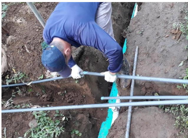
Figura 28. Construcción de laterales. Fuente: propia.
