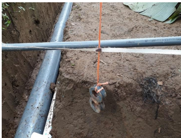
Figura 32. Nivel de las marcas de la cinta, para la distribución de los elevadores. Fuente: propia.
